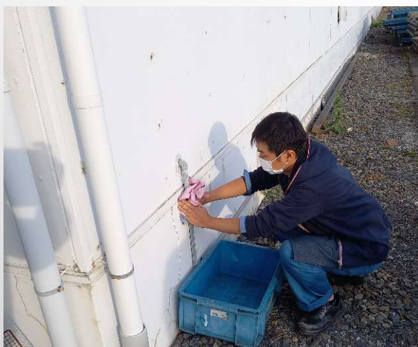
写真-2 灯油配管破損対応訓練
